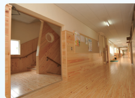
都幾川中学校校舎（内装木質化）
