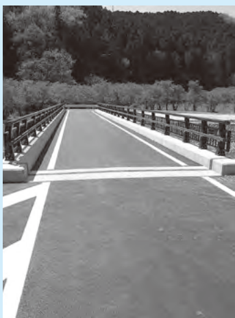
完成した下河原橋
