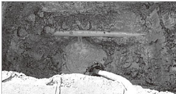
令和4年1月 皆谷地内 県道の真下で漏水(アスファルトを剥がし掘り下げての修繕)
