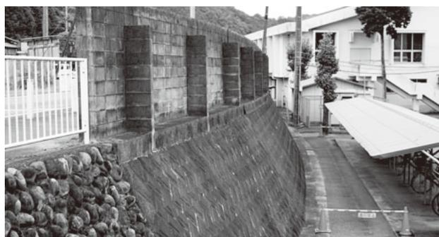
現行の建築基準法に適合していないことが判明した、中学校裏のブロック塀（「既存不適格建築物」に該当…工事の着手時には適法であったが、その後の法令の改正等により適合しなくなったもの）
