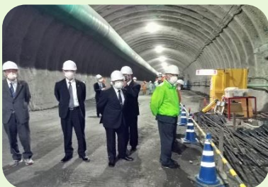
建設中の大滝トンネル
