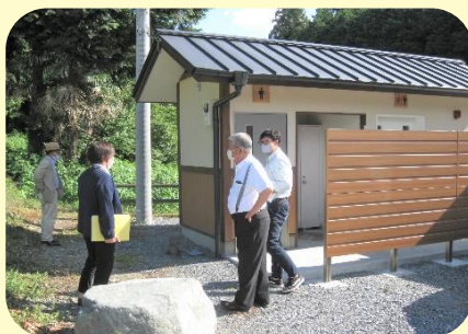
皆谷観光トイレ建設工事
