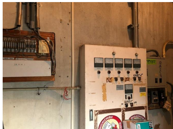
【庁舎電気設備（老朽化）】
