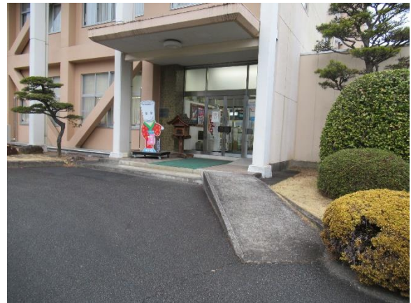
【本庁舎のスロープ】
