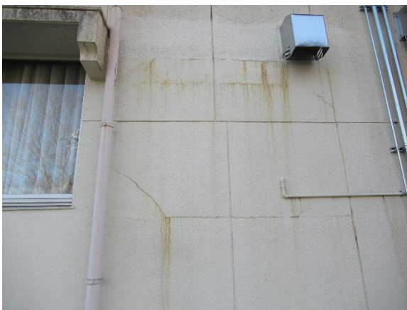
【本庁舎2階外壁（亀裂）】
