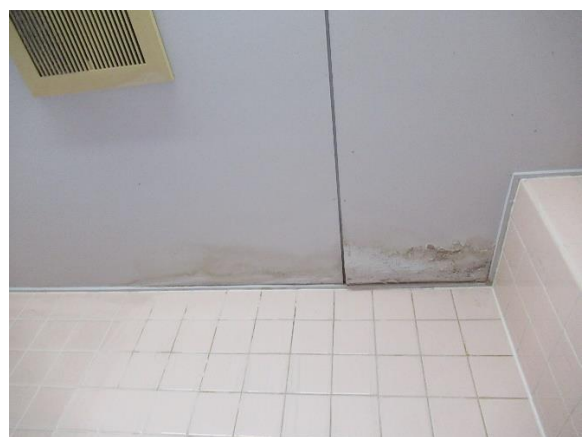
【本庁舎女子更衣室天井（雨漏り）】
