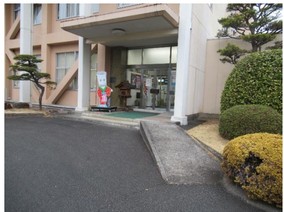
【本庁舎のスロープ】
