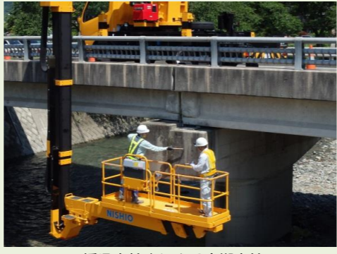
橋梁点検車による定期点検
