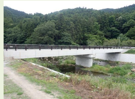
下河原橋 (35.0m 2年経過)
