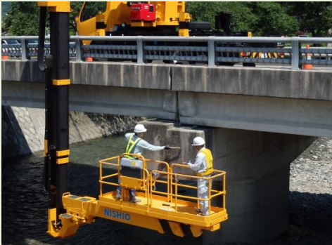
橋梁点検車による定期点検
