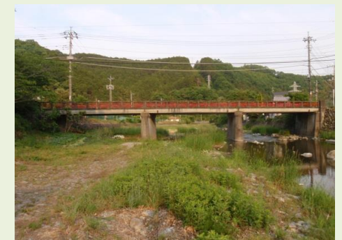
安戸橋（35.7m 60年経過）
