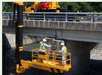
橋梁点検車による定期点検
