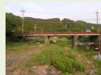
安戸橋 (35.7m 60年経過)
