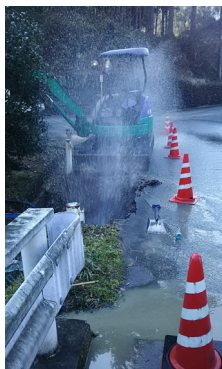
漏水復旧作業現場
