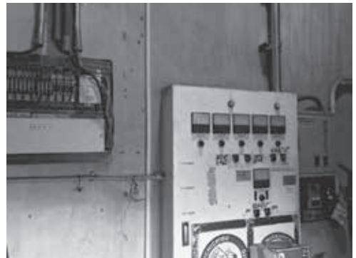
老朽化した庁舎電気設備
