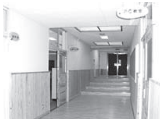
▶明るくなった2階廊下
