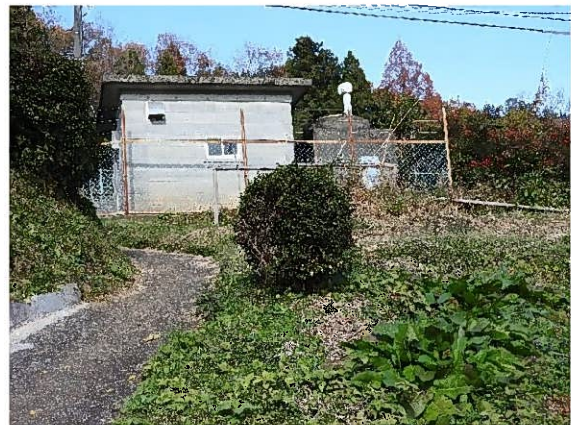
写真.栗和田ポンプ場
